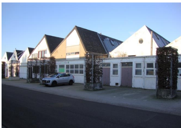
Bedrijfsverzamelgebouw (Fort Willemweg)
